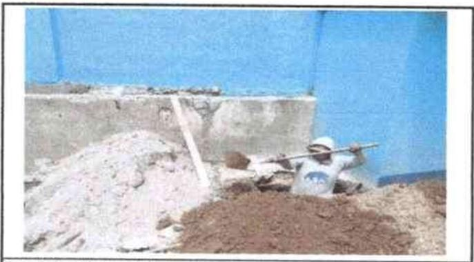
Foto 9: Cambio de red de drenaje y de caja agua potable
