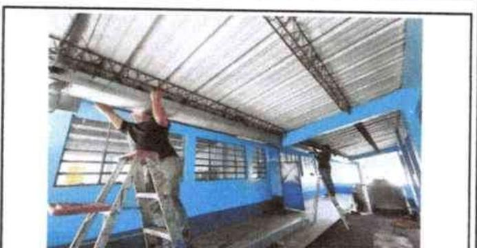
Foto 4: Cambio de canal de metal en mal estado
